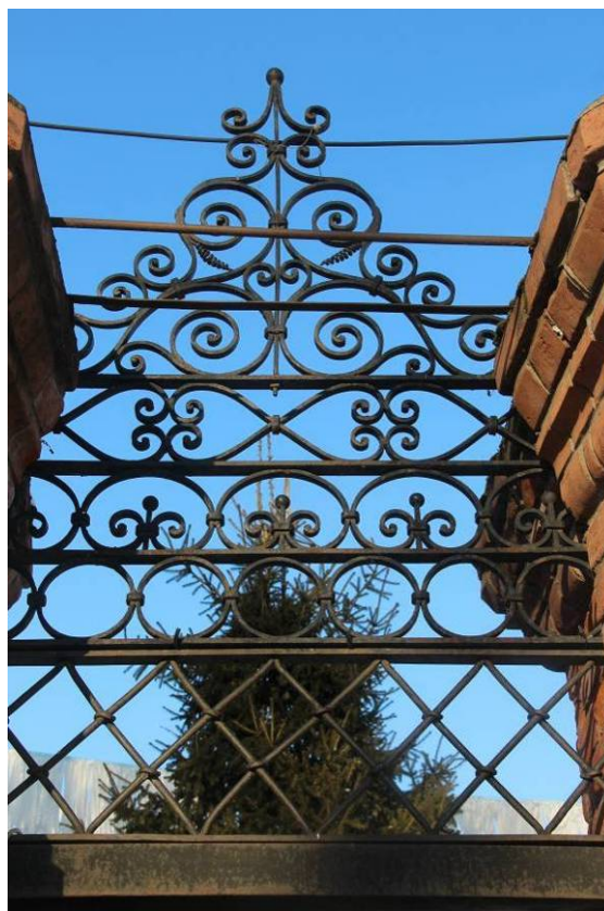
Видовая точка № 4 Решетка перемычки проема калитки (Яблонская М.А., 18.02.2025)
