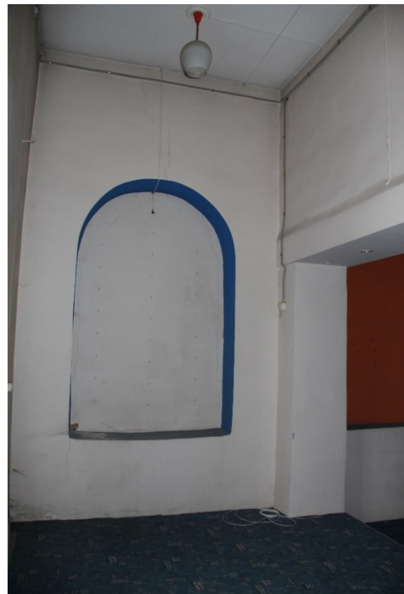
Видовая точка № 13. Заложенное окно в стене западного фасада (2 этаж)
