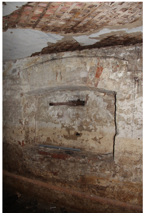
Видовая точка № 15. Оконный проём в помещении подвала
