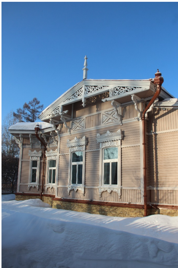
Видовая точка № 3 Фрагмент южного фасада
