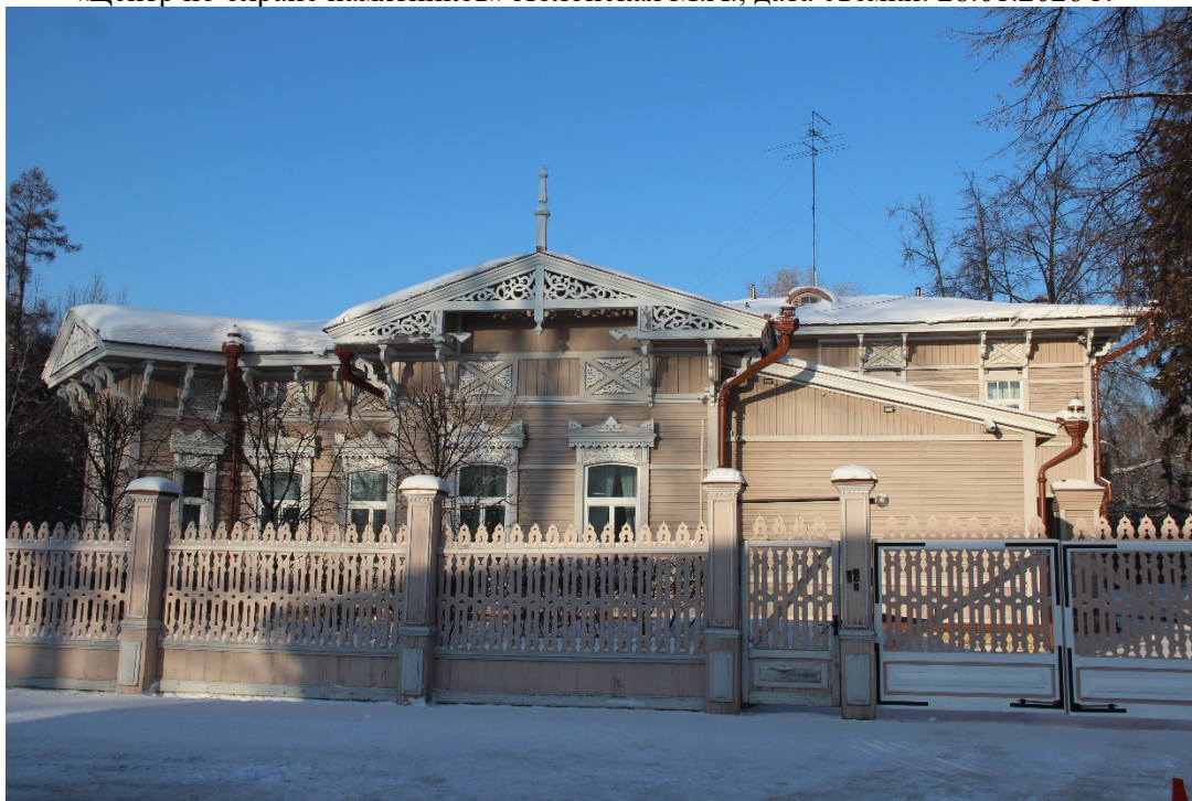
Видовая точка № 1. Южный фасад здания
