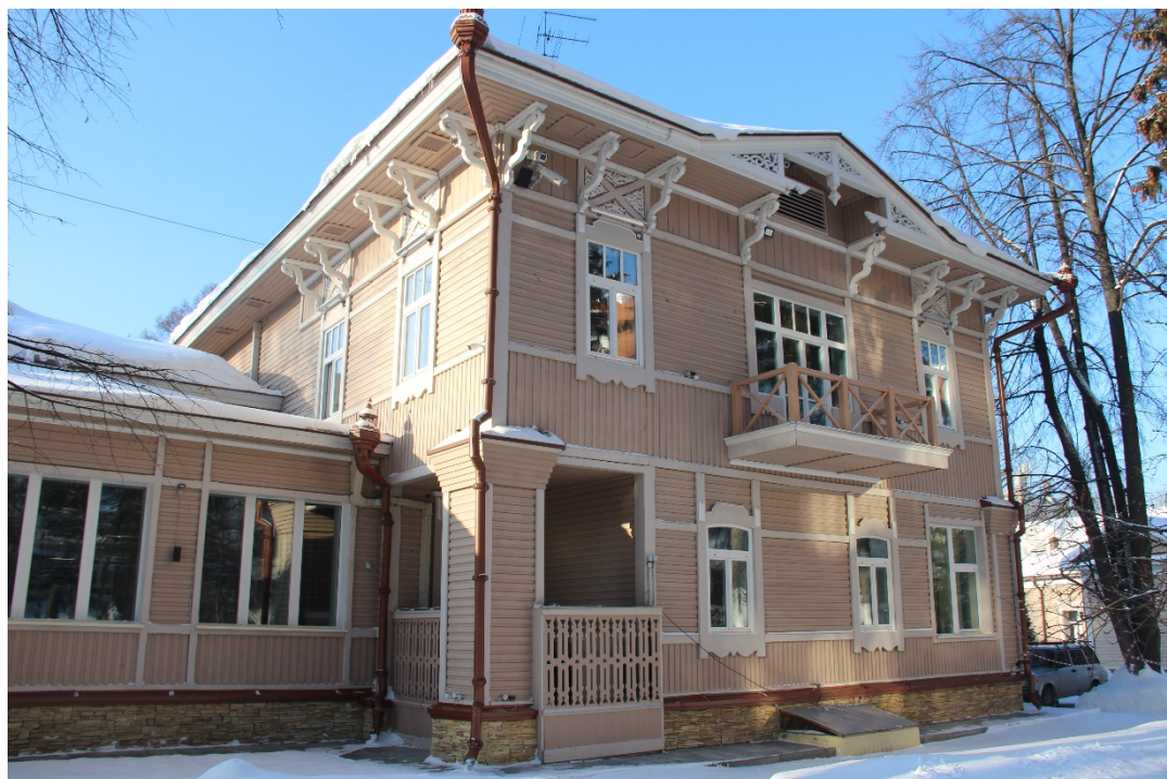
Видовая точка № 2. Фрагмент восточного фасада здания
