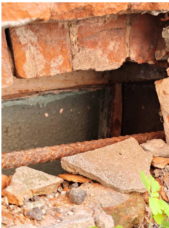
Видовая точка № 23. Заполнение (коробка) оконного проема на северном фасаде одноэтажного объёма (по оси 5, подвал)
