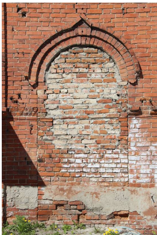
Видовая точка № 27. Арочный дверной проем выступающего объёма парадного входа южного фасада (заложен)
