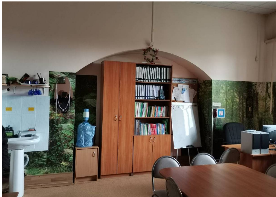
Видовая точка № 34. Арка с лучковой перемычкой в помещении 2-го этажа в западной части здания (частично заложена)
