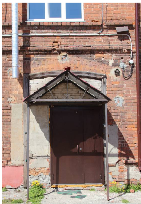
Видовая точка № 26. Дверная коробка с фрамугой на южном фасаде двухэтажного объёма (по оси 8)
