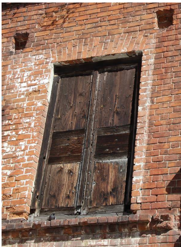
Видовая точка № 25. Деревянная двупольная филёчатая дверь с коробкой на западном фасаде двухэтажного объёма (2 этаж)
