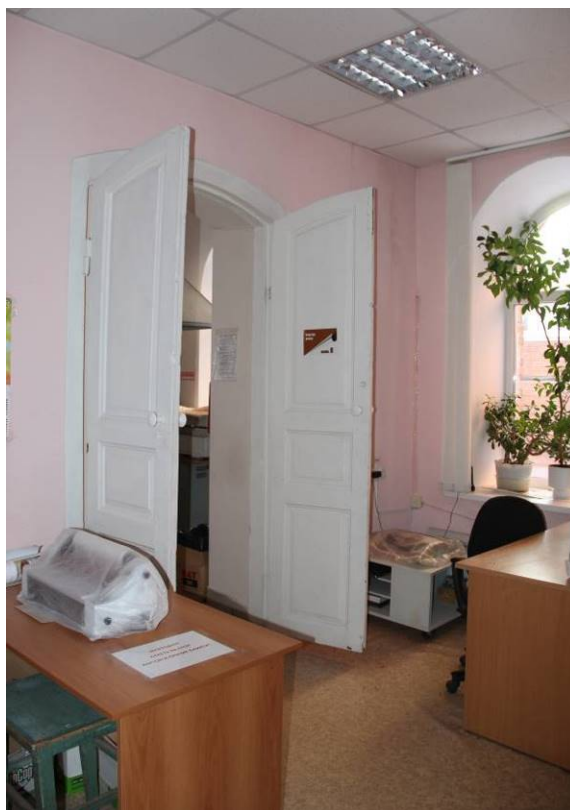
Видовая точка № 28. Деревянная двупольная филёчатая дверь с коробкой в помещении первого этажа одноэтажного объёма здания
