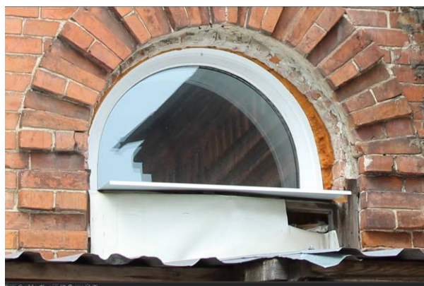
Видовая точка № 24. Заполнение оконного проема (коробка) на южном фасаде одноэтажного объёма (по оси 2, первый этаж)
