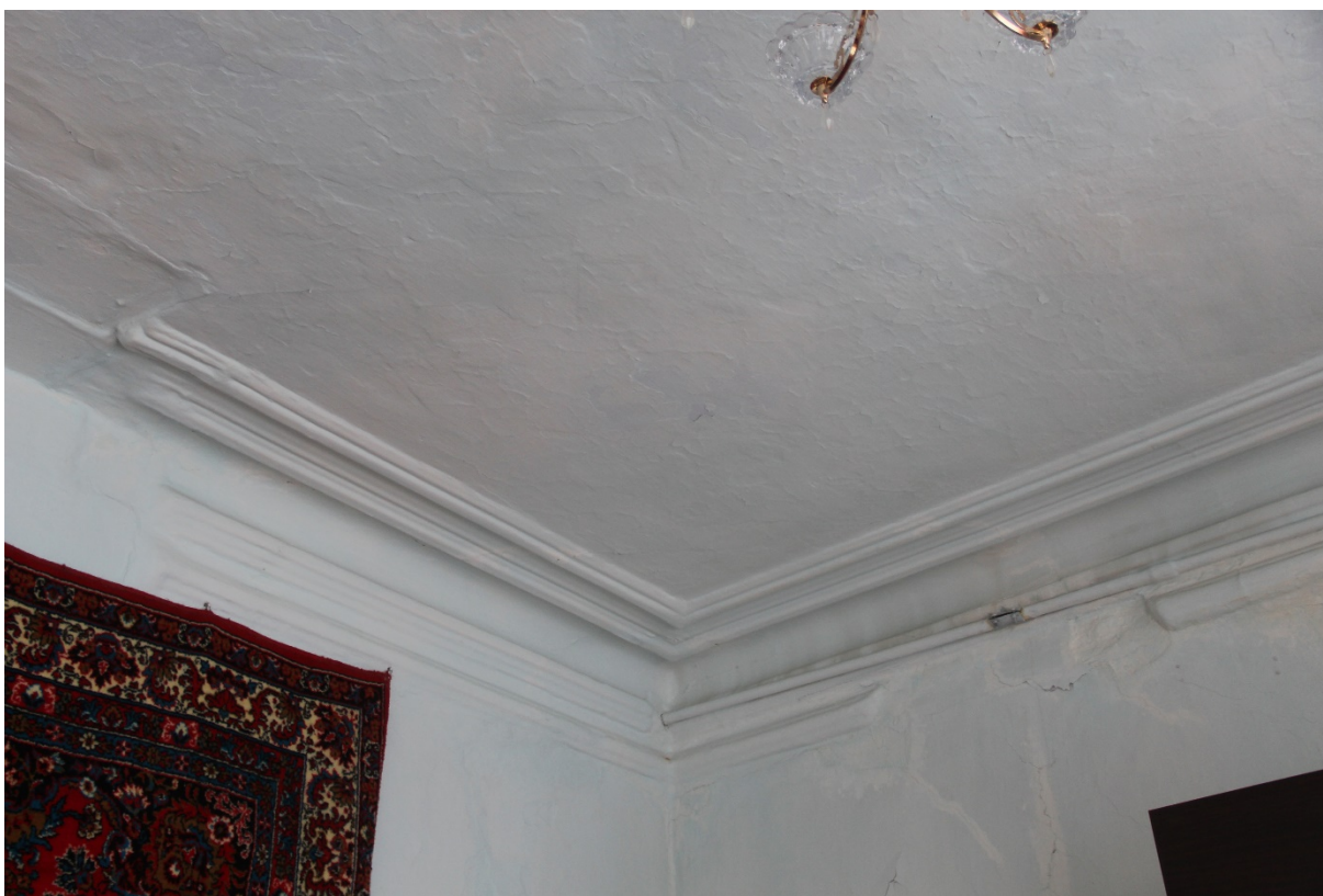
Видовая точка № 25. Карнизные тяги в помещении второго этажа (Головкова М.А., 2025 г.)
