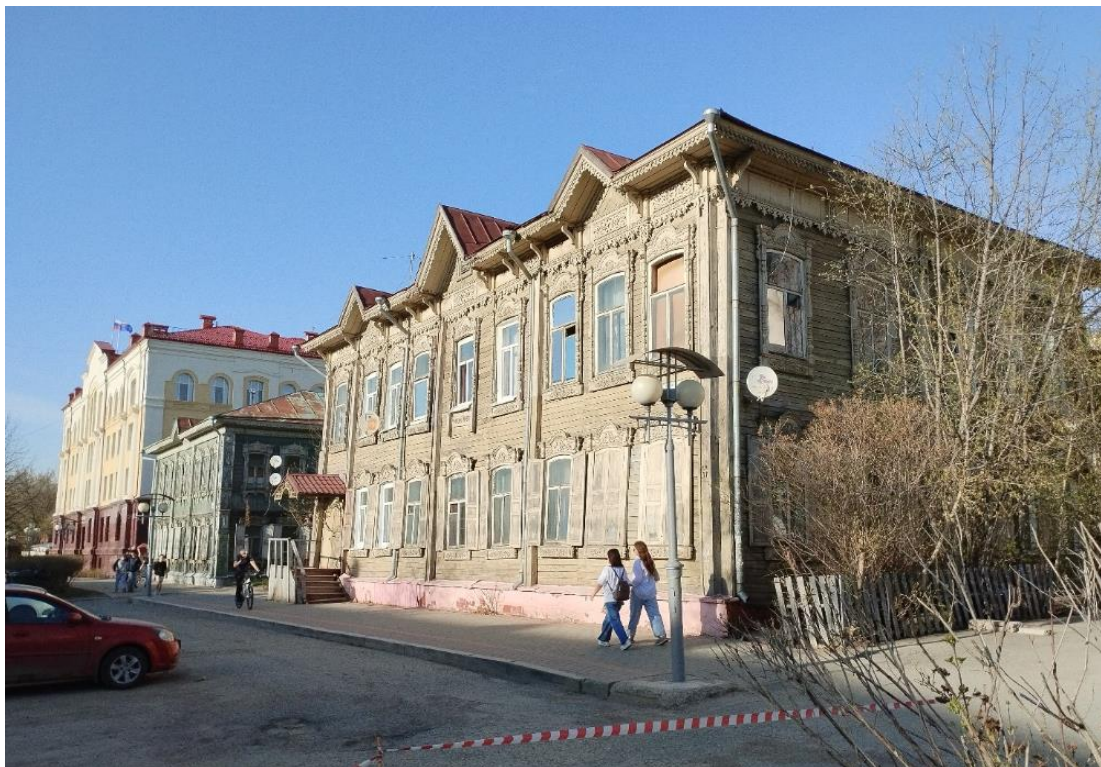
Видовая точка № 1. Вид здания в застройке проспекта Ленина (Боброва Н.П., 2026 г.)
