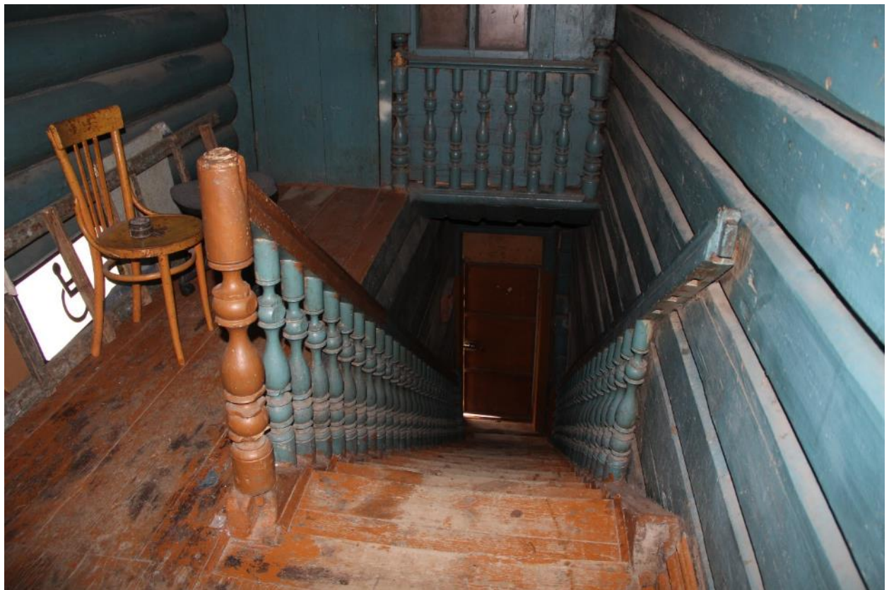
Видовая точка № 14. Деревянная одномаршевая лестница с ограждением. Стены из брёвен без обшивки (Головкова М.А., 2025 г.)
