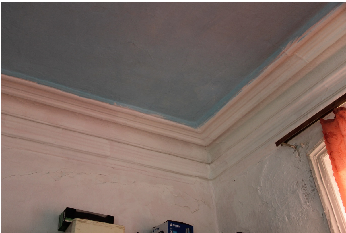
Видовая точка № 24. Карнизные тяги в помещении второго этажа (Головкова М.А., 2025 г.)
