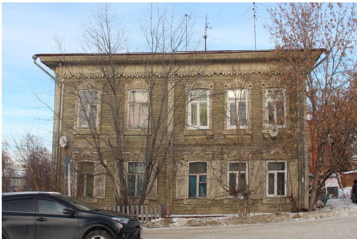
Видовая точка № 5. Общий вид южного фасада здания (Головкова М.А., 2025 г.)
