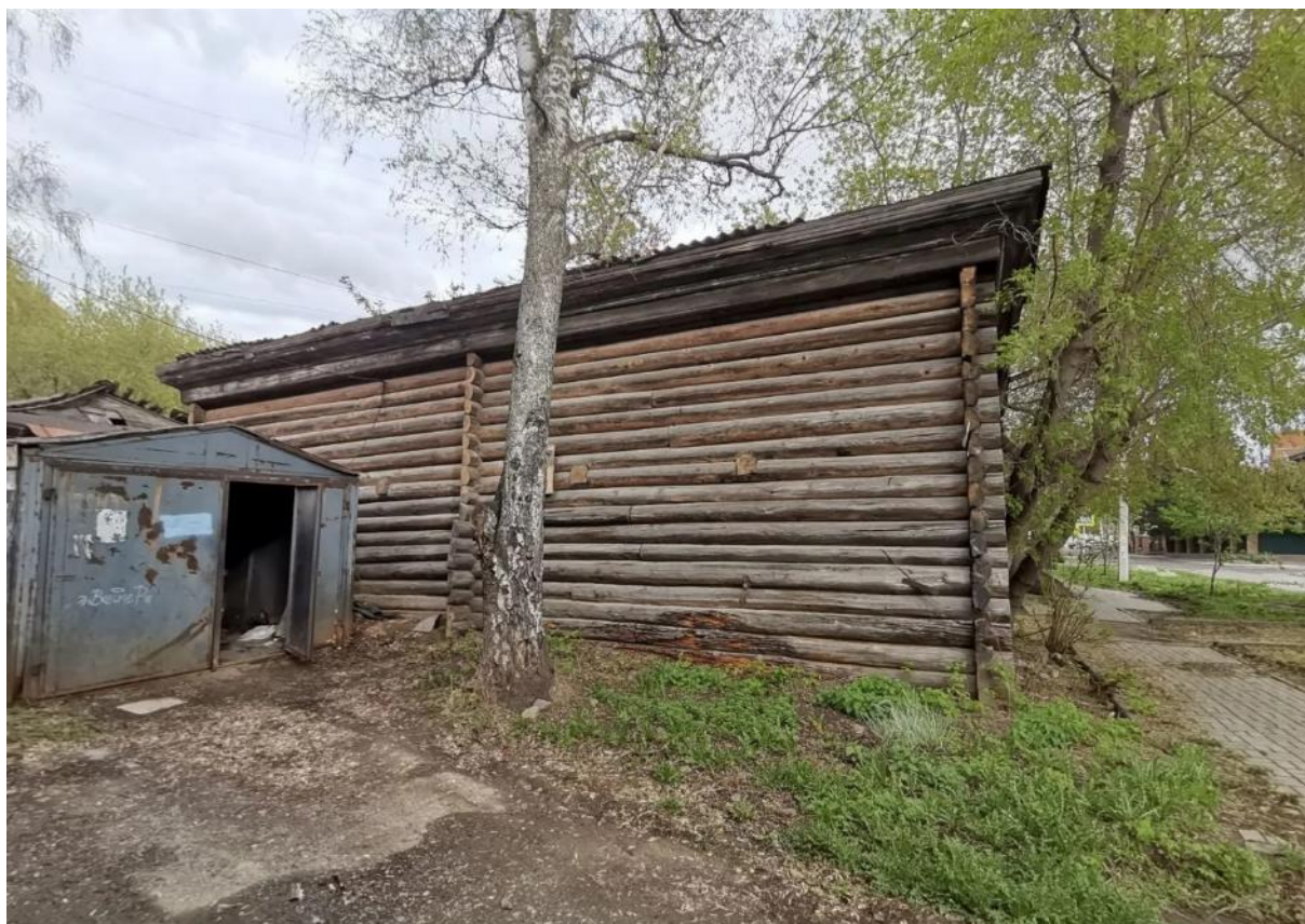
Видовая точка № 10. Конюшня. Северо-западный фасад
