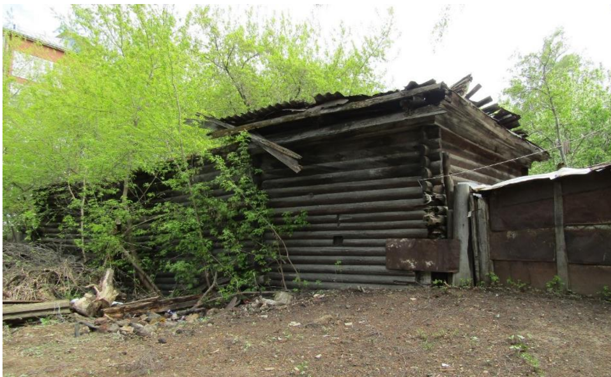
Видовая точка № 20. Амбары. Общий вид с территории смежной усадьбы
