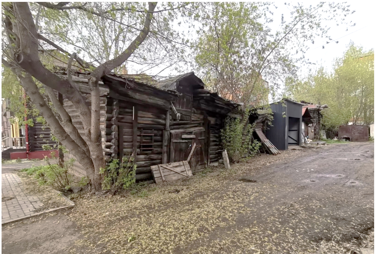
Видовая точка № 8. Надворные постройки. Общий вид с ул. Дзержинского
