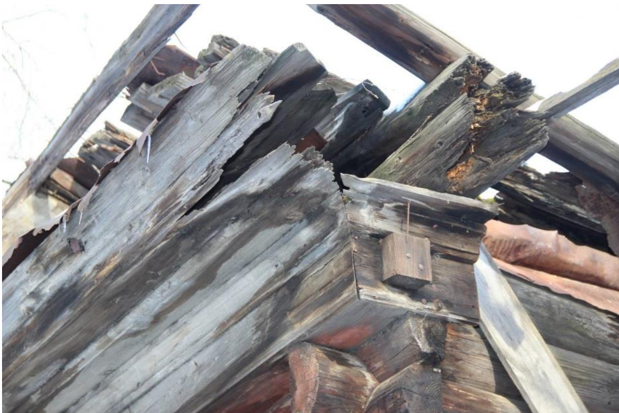
Видовая точка № 26. Амбары. Фрагмент карниза. Западный фасад
