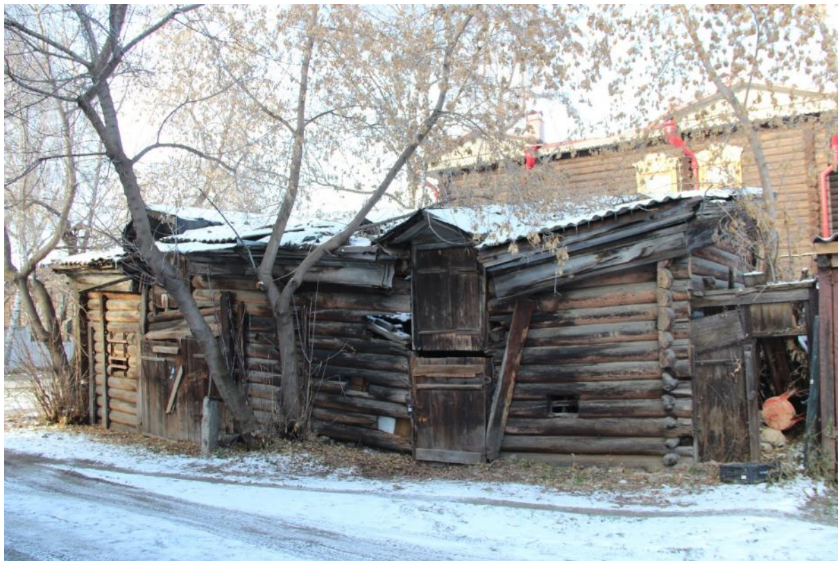
Видовая точка № 11. Конюшня. Юго-восточный фасад. Общий вид
