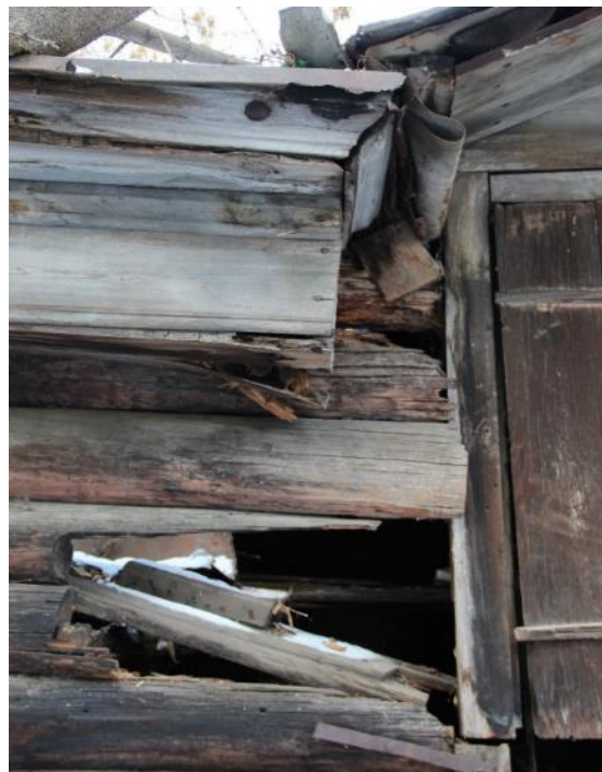
Видовая точка № 16. Конюшня. Фрагмент карниза
