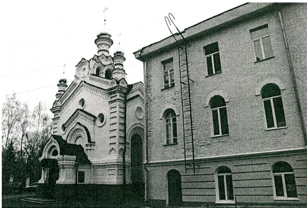
Видовая точка № 7. Западный фасад тюремной церкви. Вид со двора.
