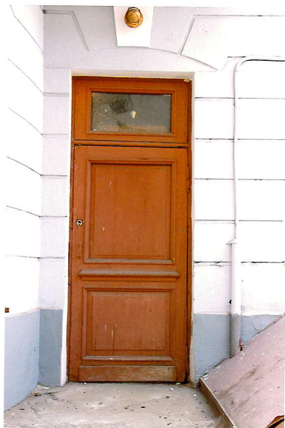
Видовая точка № 21. Южный фасад. Дверь выхода во двор.
