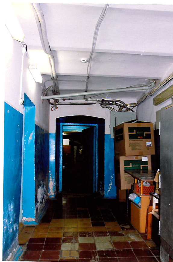
Видовая точка № 18. Фрагмент помещения подвала. Кирпичные своды перекрытия.
