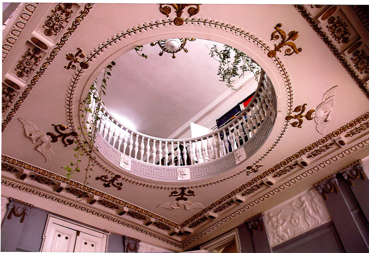
Видовая точка № 9. Общий вид потолка над парадной лестницей.
