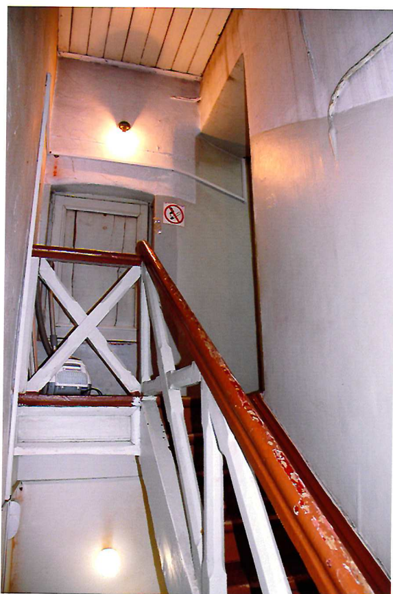
Видовая точка № 17. Деревянная лестница на 3-й этаж.
