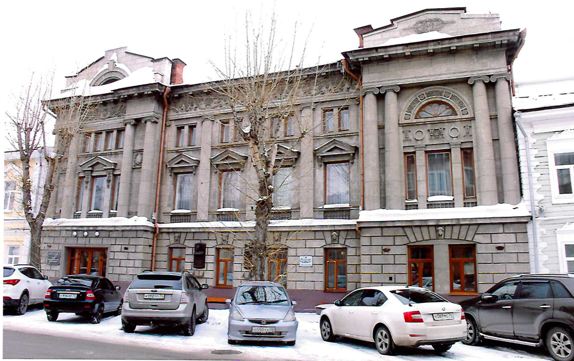
Видовая точка № 1. Главный (северный) фасад здания. (дата съемки: 09.04.2015 г.).
