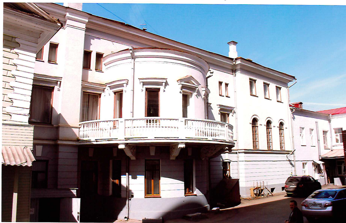
Видовая точка № 2. Дворовый (южный) фасад здания.
