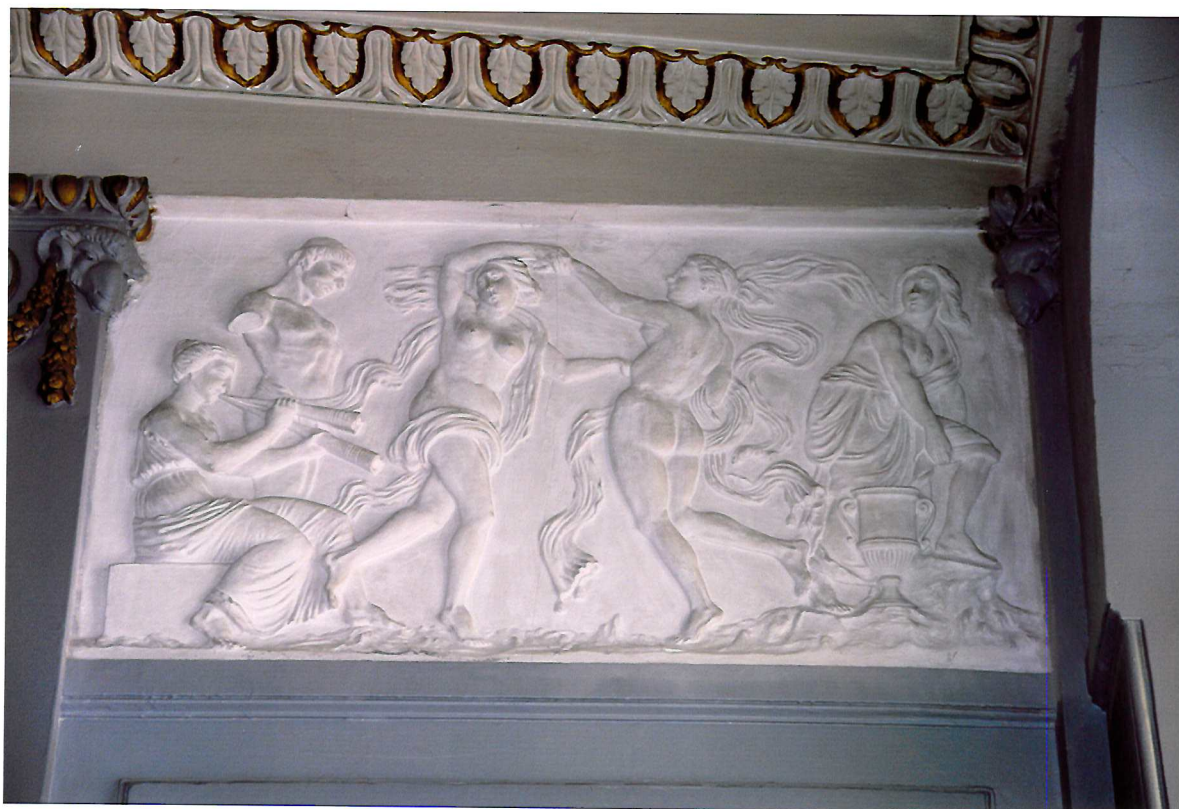
Видовая точка № 19. Помещение парадной лестницы в уровне 2-го этажа. Настенный барельеф.
